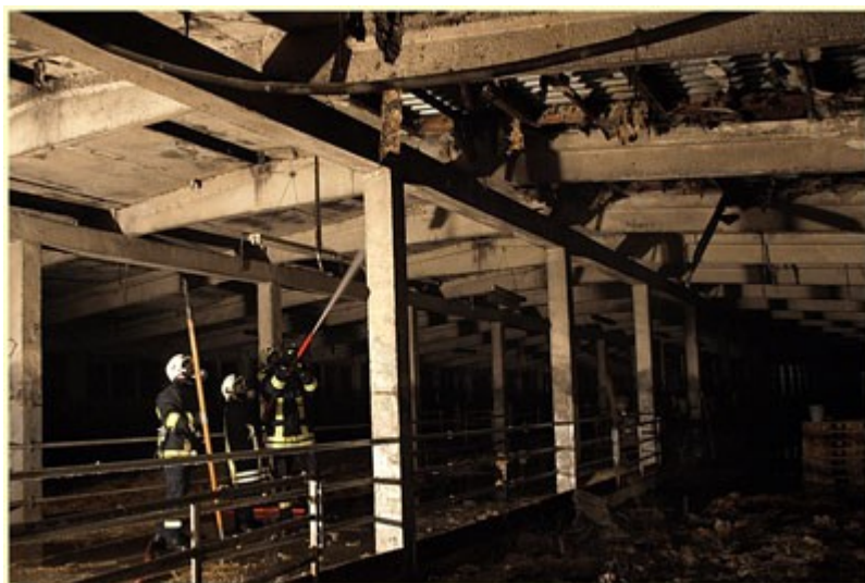
Arbeiten am Dach
